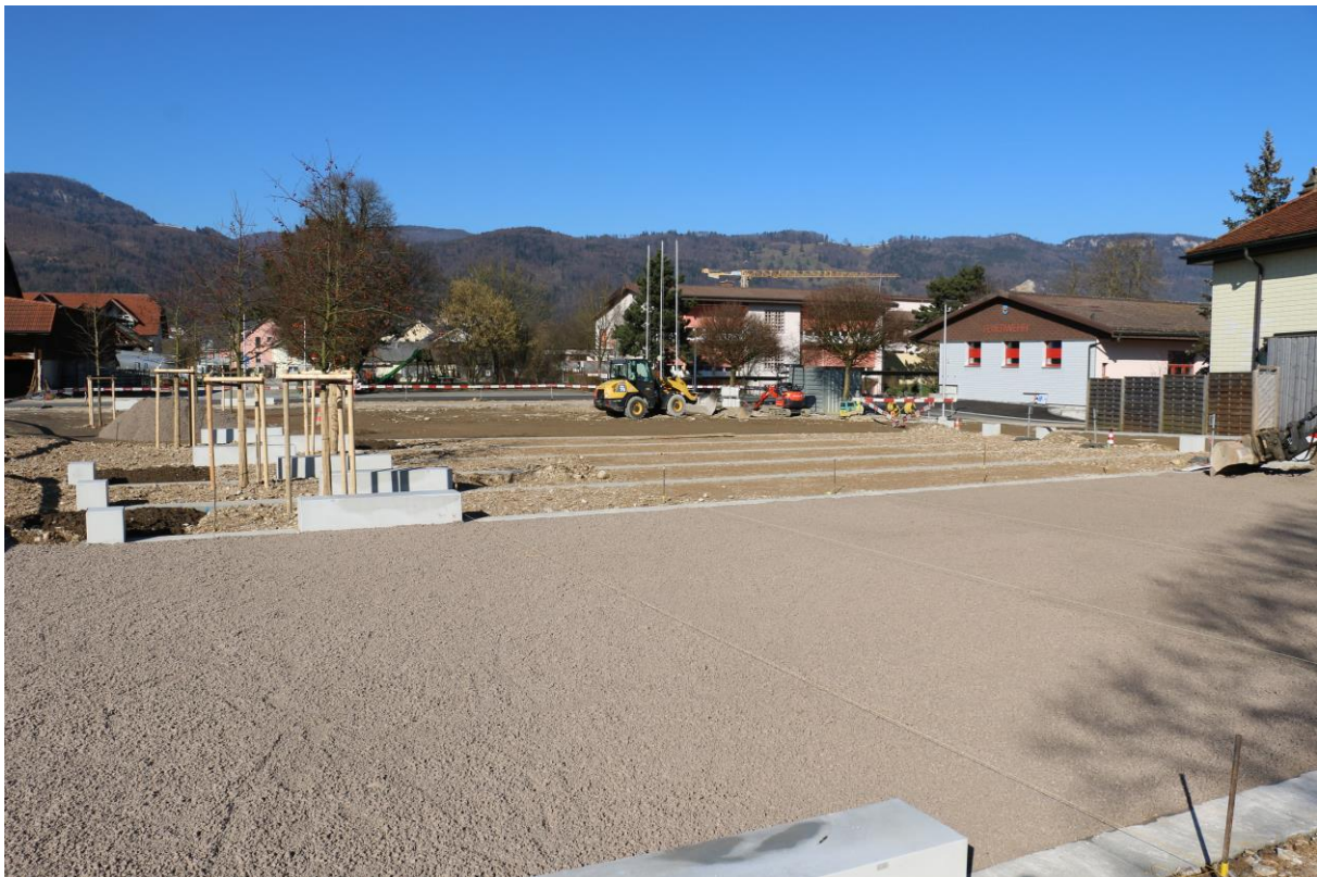
Bauarbeiten am neuen Dorfplatz
